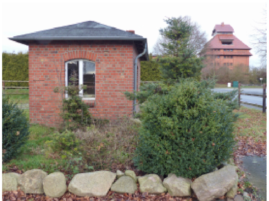
Wiegehaus mit Speicher im Hintergrund
