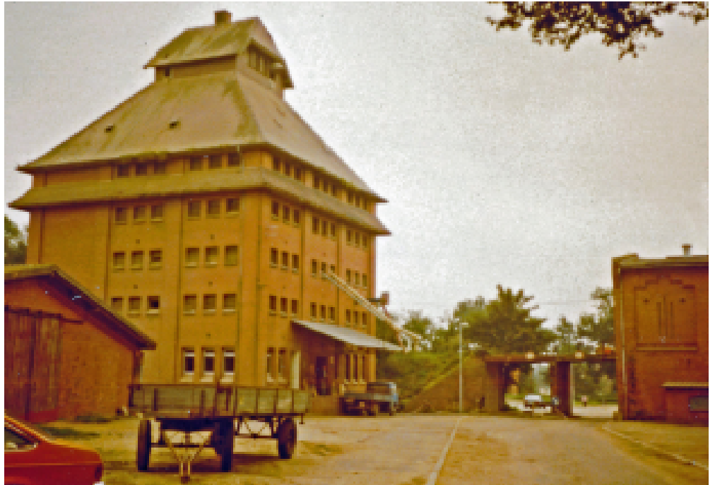
Speicher mit Auffahrt zum ehemaligen 1.Stock des Kuhstalles auf dem Gutshof 1981
