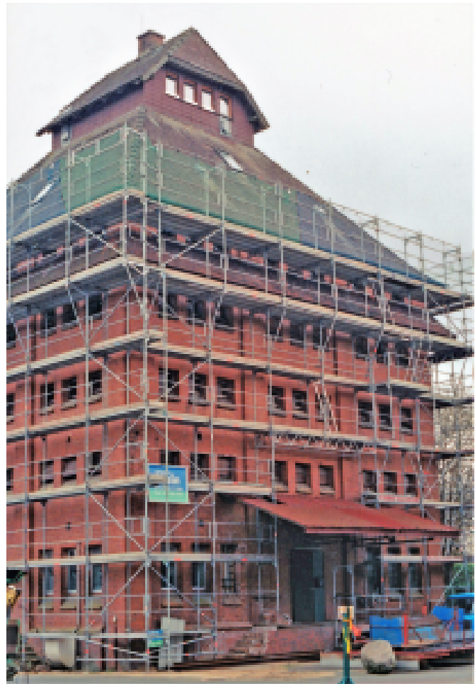
Frühjahr 2004, Einrüstung des Speichers
