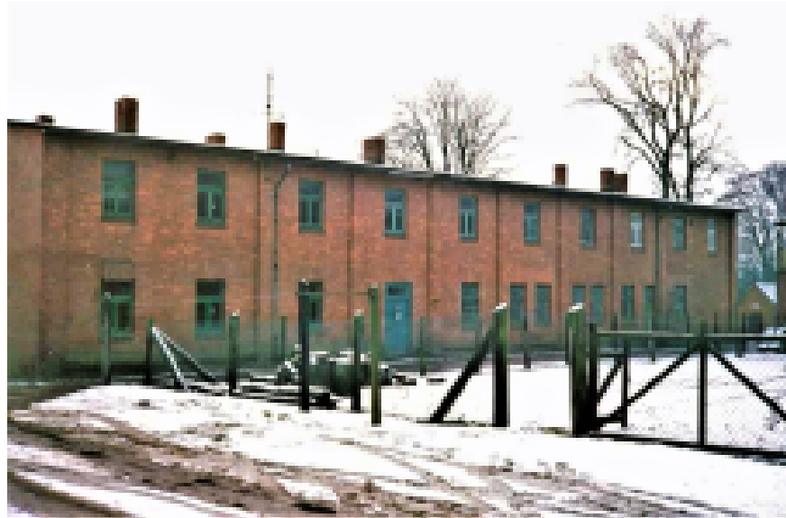
ehemalige Schnitterkaserne an der Dorfstraße, 1988 abgebrochen
