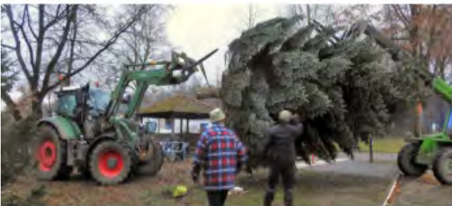
Der letzte Akt, das Aufstellen des Baumes
